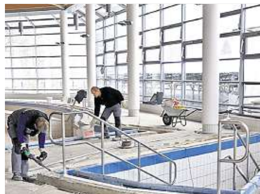
■ Rund 40 Gewerke waren mit dem Wiederaufbau beschäftigt. Fotos: KEG Pirna
