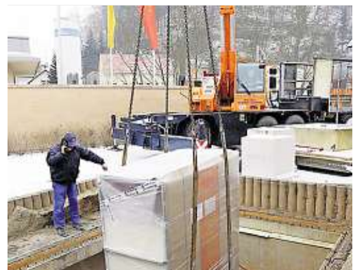
■ Eine logistische Meisterleistung: Die neue Technik wird in den Keller gehievt.
